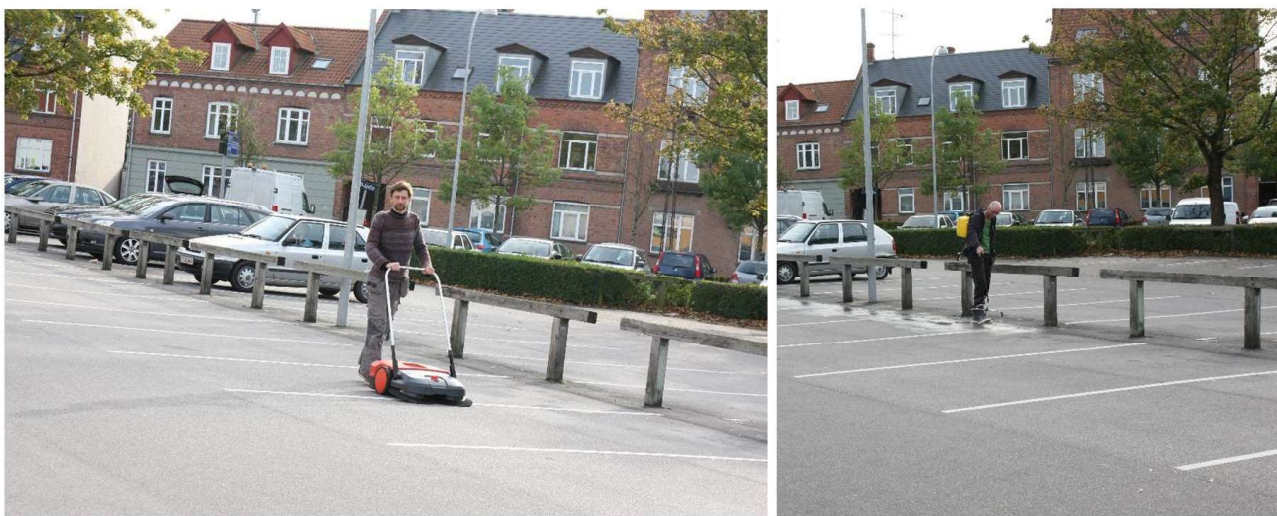
Figur 36: Manuel fejning af parkeringspladsen og applicering af den fotokatalytiske væske
